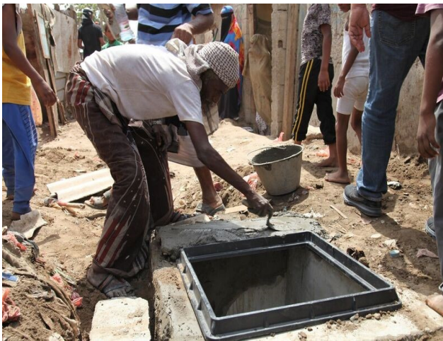
عامل بناء أثناء إصلاح أنابيب الصرف الصحي في منطقة دار سعد، عدن. إصلاح المجاري يأتي كجزء من مشروع اليونيسف والبنك الدولي ومنظمة الصحة العالمية في مجال الصحة والتغذية في حالات الطوارئ بهدف مكافحة الكوليرا ودعم النظام الصحي في اليمن. الصورة من: معتز فؤاد، اليونيسف.
